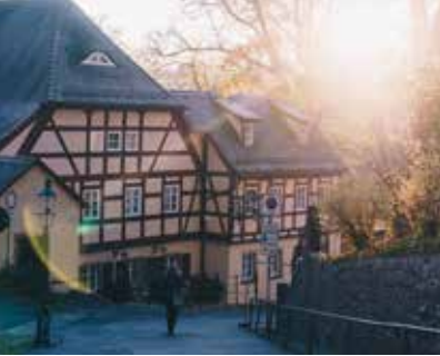
Kellerhaus am Schloßberg
